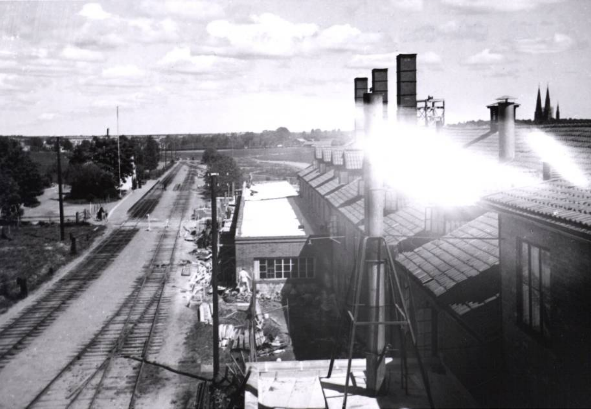
Fabriksbyggnad under uppförande den 30 juni 1951.
